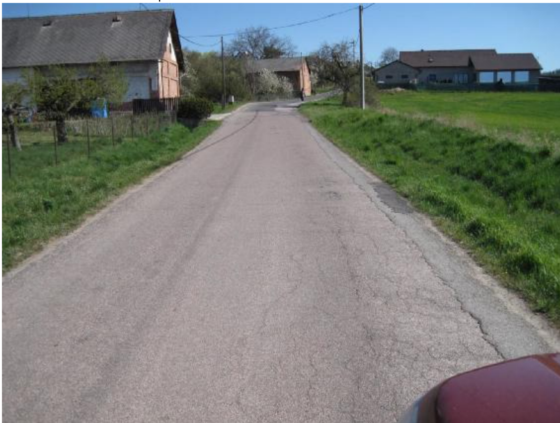
F89, km 0,800+ Síťové trhliny, neudržované odvodnění.
