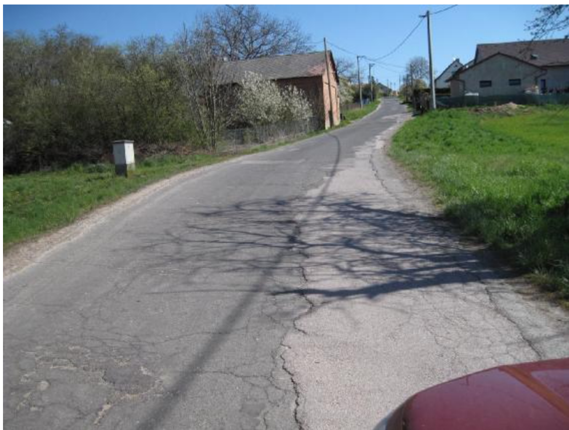
F91, km 0,850+ Síťové trhliny, plošné deformace, vysprávkky, zvýšené krajnice.
