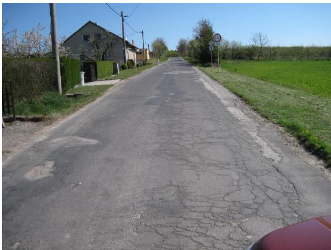
F101, km 1,100+ Síťové trhliny, plošné deformace, vysprávkky, zvýšené krajnice.
