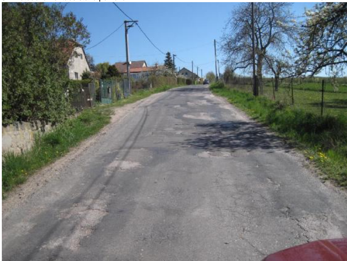
F97, km 1,000+ Síťové trhliny, plošné deformace, vysprávkky, zvýšené krajnice.
