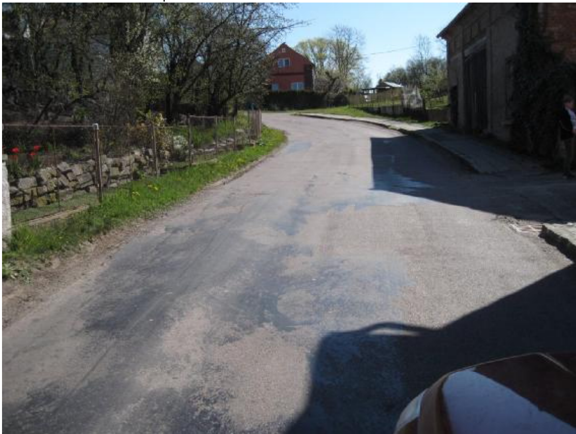
F75, km 0,450+ Plošné deformace a ztráta makrotextury.
